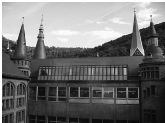
Los modernos techos de la biblioteca de la Universidad de Heidelberg conviven con los edificios antiguos.
